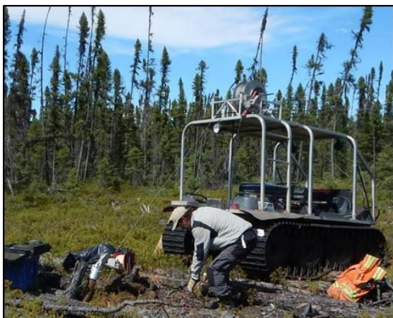
Photo 3. Montage du bailer sur l'ARGO. Le treuil (500 m) est fixé sur le toit de l'ARGO, puis le câble glisse sur une poulie fixée sur le sommet du tubage, ce qui permet la descente du bailer dans le puits.
